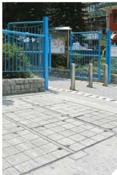
Tapas para C250 se manufacturan en modelo sólido o rellenable de hormigón.
