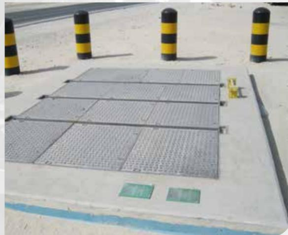
El tipo de carga se clasifica siguiendo la normativa BS EN 124: (Sumideros y tapas de pozos para áreas vehiculares y peatonales, requisitos de diseño, test de pruebas , marcaje y control de calidad ).
